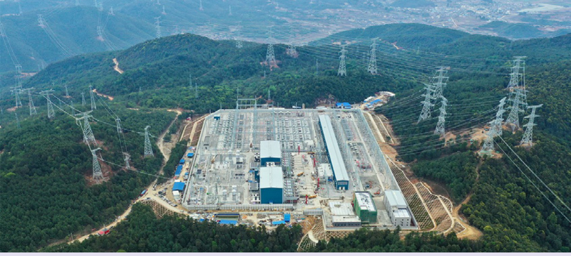
(ABB Power Grids ile China Southern Power Grid Projesi- Yunnan-Guizhou HVDC İletim Hattı Projesi) 57
